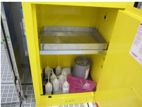
化學品貯存櫃設置防漏承接盤
